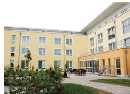
Casa di riposo Regensburg-Burgweinting: gestione centralizzata degli apparecchi M-WRG e uso dell'economica soluzione 2-locali.
