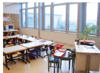
Scuola a Waldburg: Posa degli apparecchi M-WRG nell' parapetto della finestra
